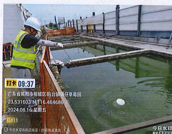
施工 3 标 GX11 生产废水
