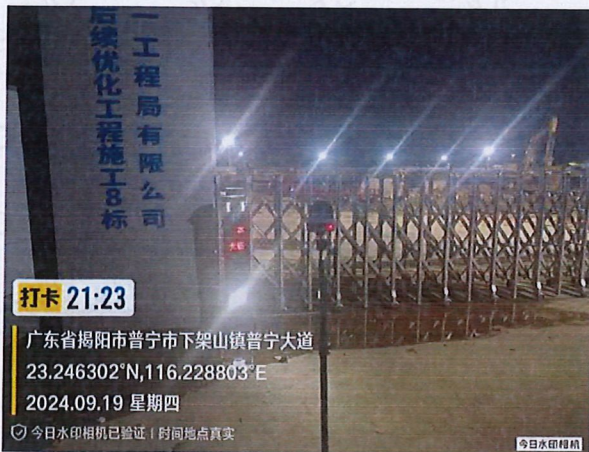
玉丰村（下架山泵站）北侧外 1m1#
