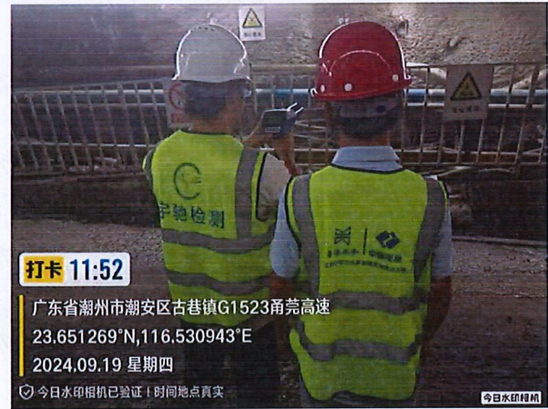
主干线隧洞段 1#支洞 100 米处
