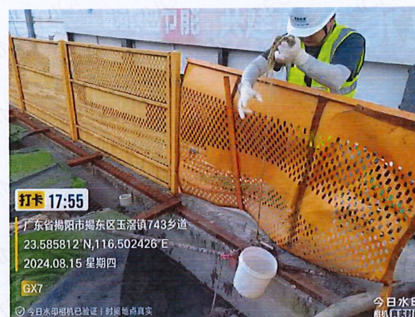
施工 2 标 GX7 生产废水
