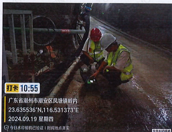
主干线隧洞段 2#支洞 200 米处
