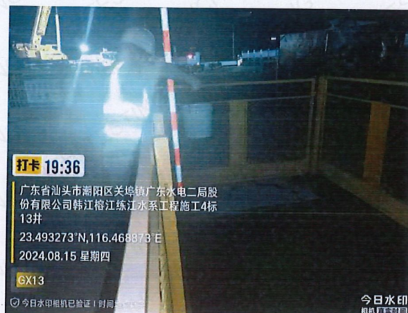
施工 4 标 GX13 生产废水
