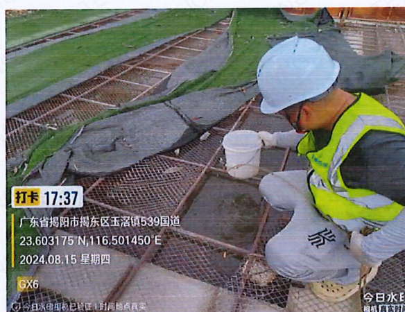
施工 3 标 GX6 生产废水
