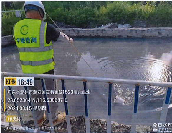
施工 1 标 1#支洞隧道洞口排水
