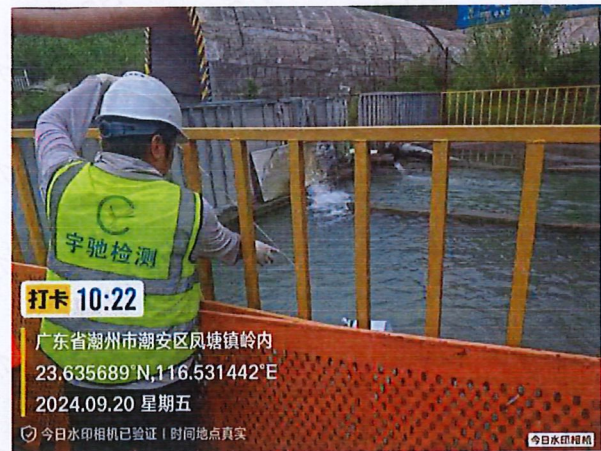
施工 1 标 2#支洞隧道洞口排水
