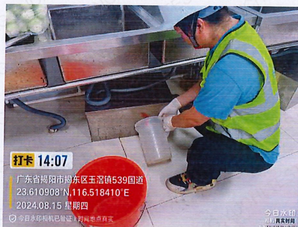
施工 3 标 GX5 厨房生活污水（1 号点）
