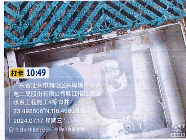
施工 4 标 GX13 厨房生活污水
