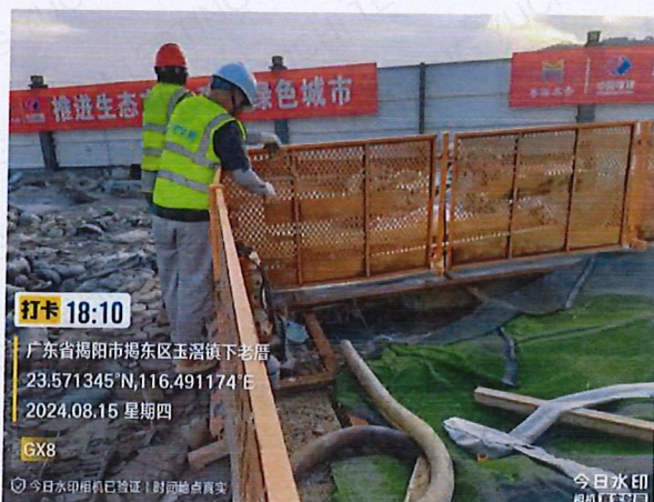
施工 2 标 GX8 生产废水
