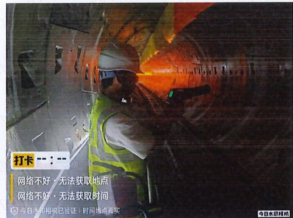
TBM 隧道洞口开端 400 米处
