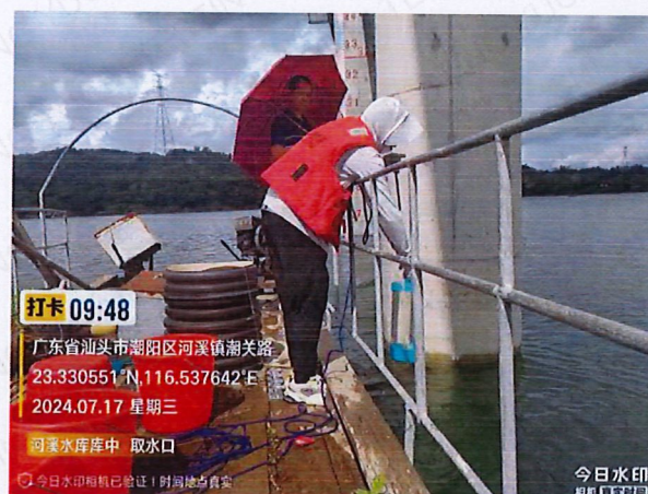
河溪水库取水口
