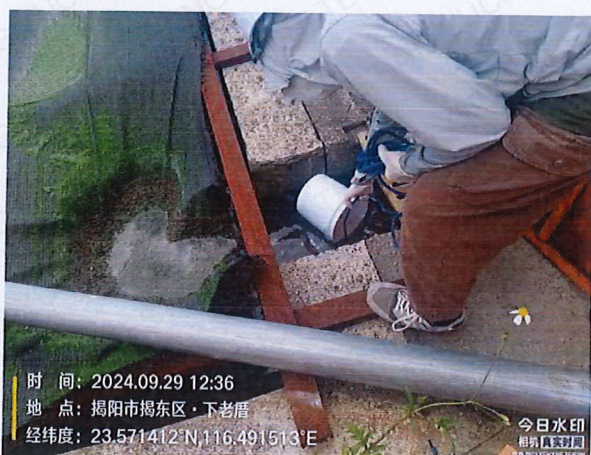
施工 2 标 GX8 生产废水
