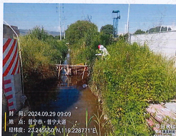
下架山泵站 1 生产废水
