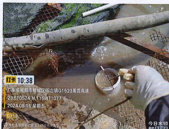
施工 2 标 GX12 生产废水
