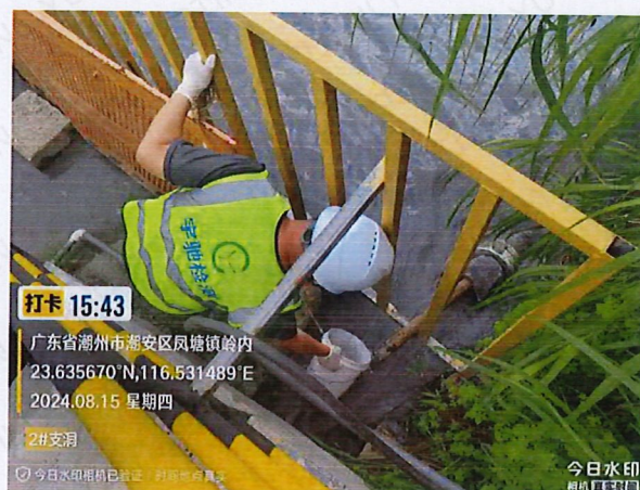
施工 1 标 2#支洞隧道洞口排水
