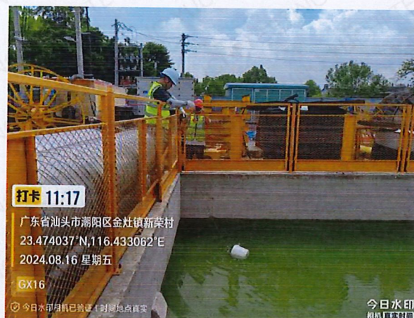
施工 4 标 GX16 生产废水
