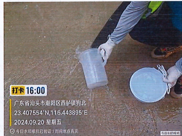
施工 5 标 TBM 隧道开端洞口排水
