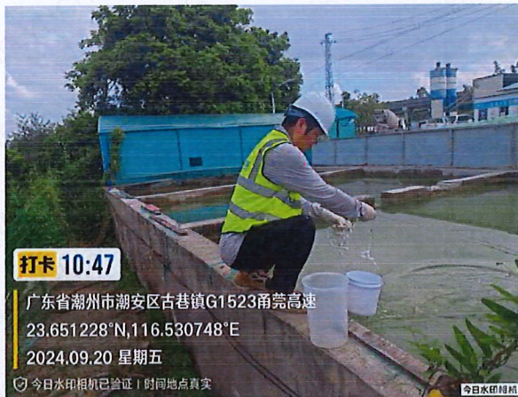
施工 1 标 1#支洞隧道洞口排水
