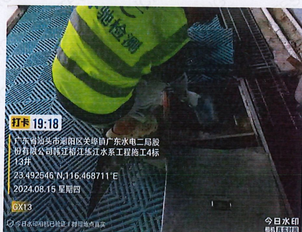
施工 4 标 GX13 厨房生活污水
