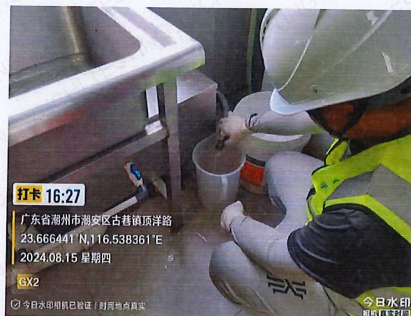
施工 1 标 GX2 厨房生活污水
