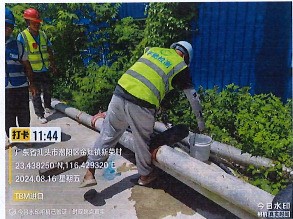
施工 5 标 TBM 隧道开端洞口排水
