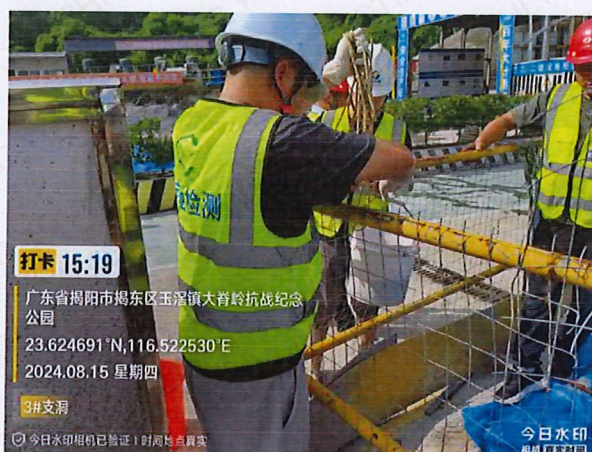
施工 1 标 3#支洞隧道洞口排水
